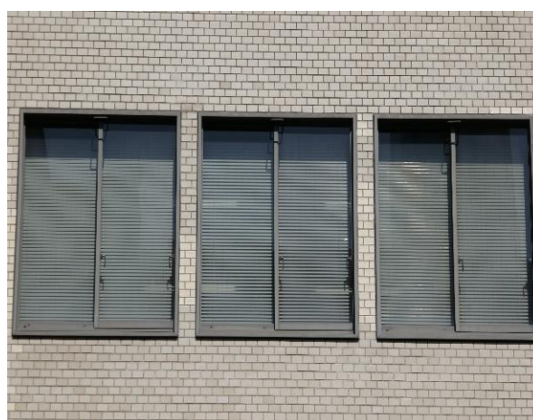
【窓ガラスに遮熱フィルム貼付】
