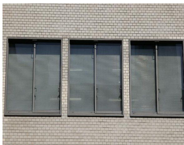
【窓ガラスに遮熱フィルム貼付】
